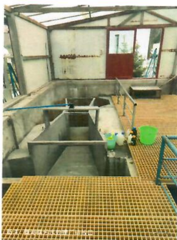
图6-1 污水厂末端排放口处
