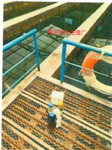
图6-1 污水厂末端排放口处
