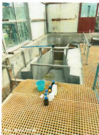
图6-1 污水厂末端排放口处
